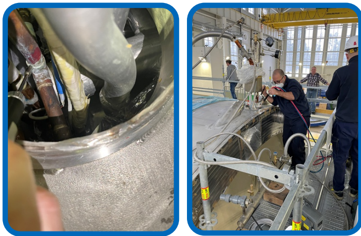
Рис. 8. Локализация (слева) и ремонт (справа) азотного контура теплового экрана соленоида.
