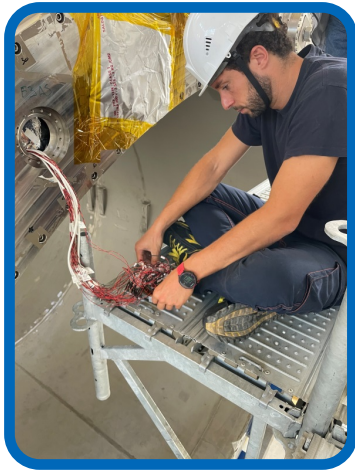
Рис. 10. Замена вышедшего из строя разъема. Fig. 10. Replacing the failed connector.
