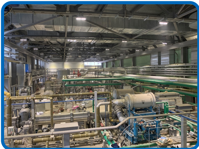
Рис. 18. Смонтированное технологическое оборудование криогенно-компрессорной станции.
