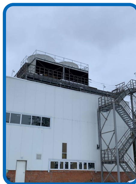
Рис. 19. Блочно-модульная вентиляторная градирня «Marley NC8409».
