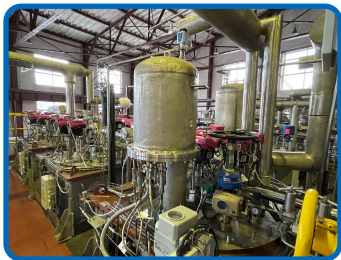
Рис. 12. Гелиевый спутниковый рефрижератор РСГ-2000/4,5 №1 Бустера. Fig. 12. The helium satellite refrigerator RSG-2000/4.5 No. 1 of the Booster.
