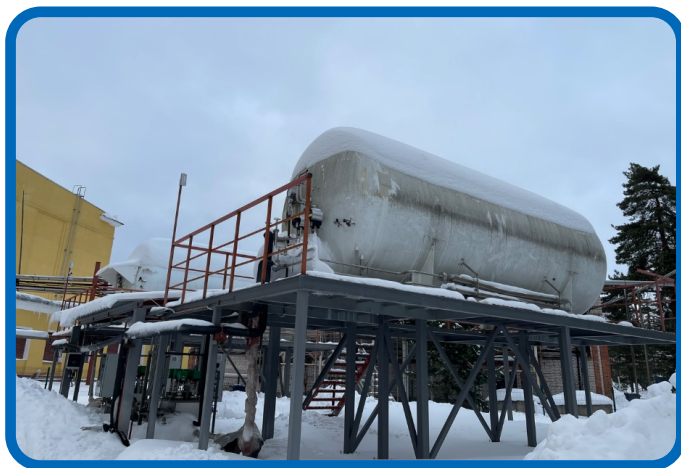
Рис. 14. Тридцатикубовый азотный танк VRV. Fig. 14. Thirty m 3 VRV nitrogen tank.
