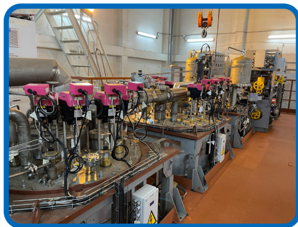
Рис. 15. Гелиевые спутниковые рефрижераторы РСГ-2000/4,5 №2 и 3 коллайдера. Fig. 15. Helium satellite refrigerators RSG-2000/4.5 No.2 and 3 of the collider.
